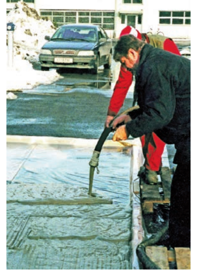
Qışda açıq sahənin döşəməsinin töküləsi
