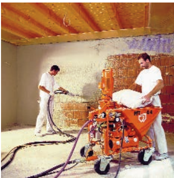
Qarışdırıcı qüllə təmizləmə və daşınma üçün asan çıxarılır
