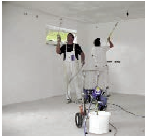
Səth üzərində diyirlənən vərdənəli tapançanın köməyi ilə dispersion boyanın havasız vurulması
