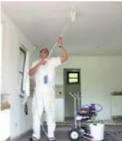
Xüsusi vərdənənin köməyi ilə dispersion boyanın havasız vurulması
