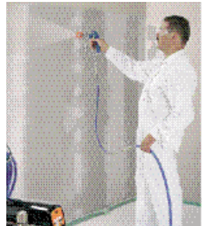
Pastaşekilli üzlük suvağın havasız çilənməsi
