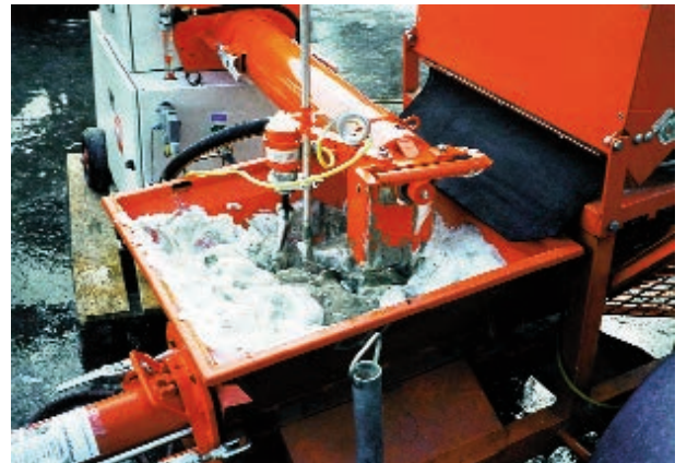
Duru köpüklü beton basma nasosun qəbul bunkerinə tökülür
